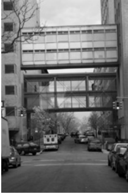
Puente hacia otra parte
